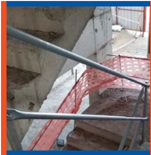
Ayarlanabilir Yatay Bağlantı Adjustable Horizontal Brace Barre Horizontale Ajustable
